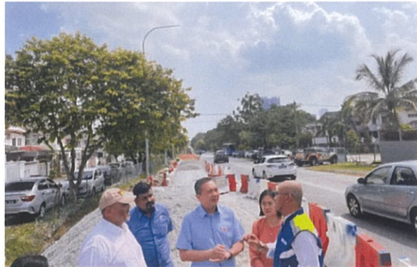
Ahli Dewan Negeri (ADN) Kinrara Ng Sze Han (tengah) meninjau kerja naik taraf Jalan Puchong Jaya pada 30 Julai 2024. Foto ZULFADHLI ZAKI/MEDIA SELANGOR
