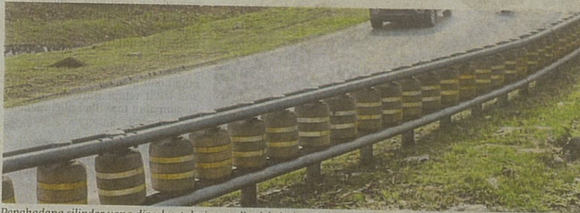
Penghadang silinder yang diperbuat dari span di selekoh dari Terminal SkyPark Subang ke Lebuhraya Persekutuan antara pilihan menggantikan penghadang besi. (Foto Fathil Asri/BH)
