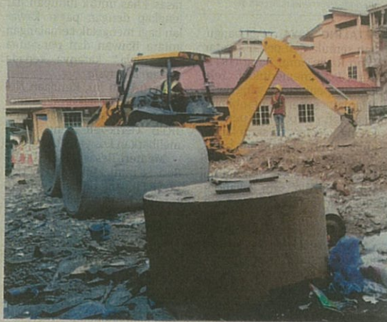
SYARIKAT kontraktor membersihkan tapak rumah yang terjejas akibat letupan gas di Putra Heights pada 1 April bagi memulakan kerja pembinaan semula rumah yang rosak.
