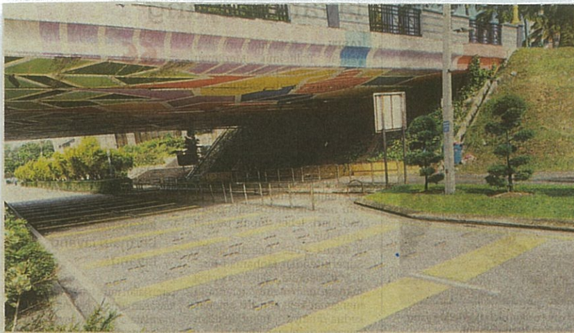
LALUAN di Persiaran Perbandaran, Seksyen 14, Shah Alam yang dipasang pepaku jalan atau road stud.
