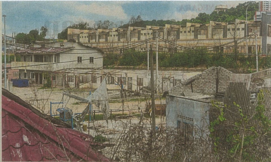
KEADAAN terkini kawasan perumahan yang musnah akibat insiden kebakaran saluran paip gas di Putra Heights pada 1 April lalu.
